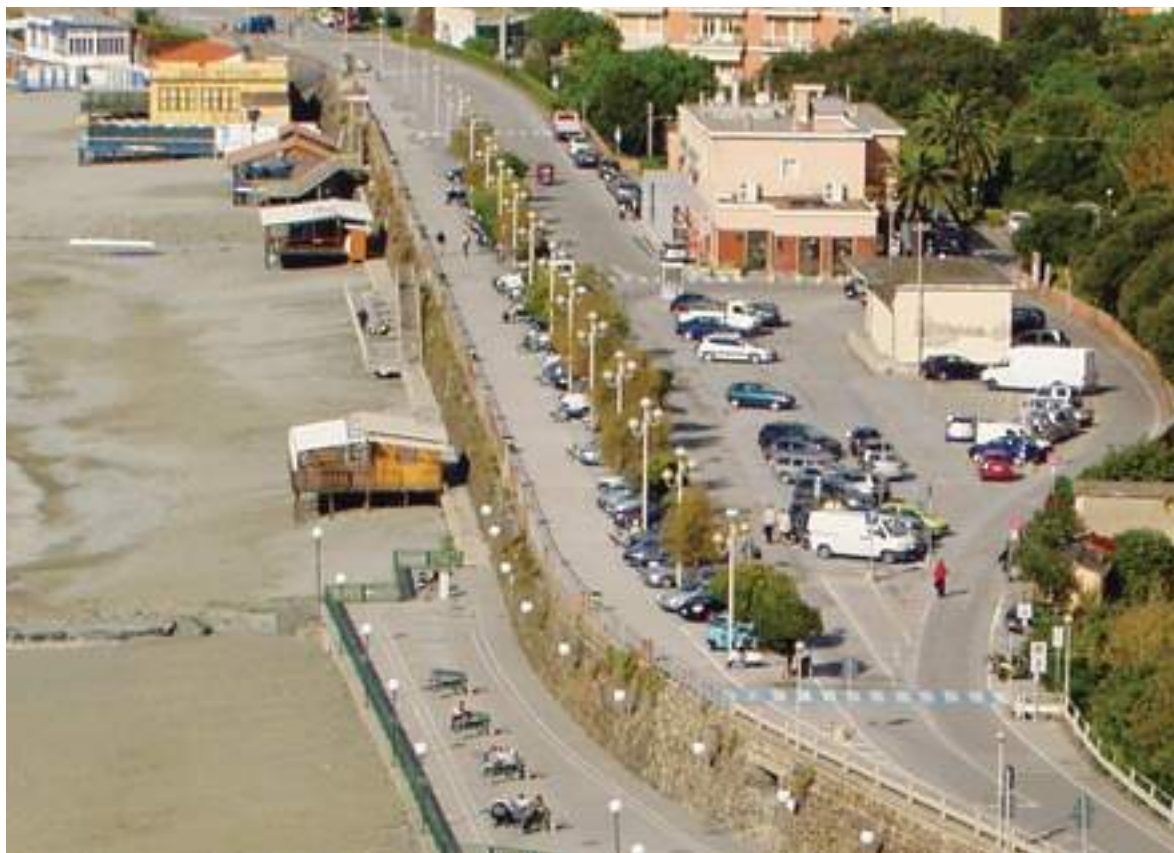
La zona del lungomare interessata al secondo lotto dei lavori. Tra le opere il parcheggio interrato con alcuni box
