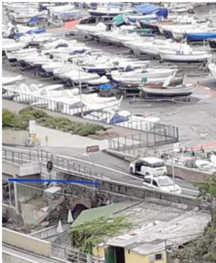
I tecnici di Acam e i vigili sul depuratore di Levanto, ieri
