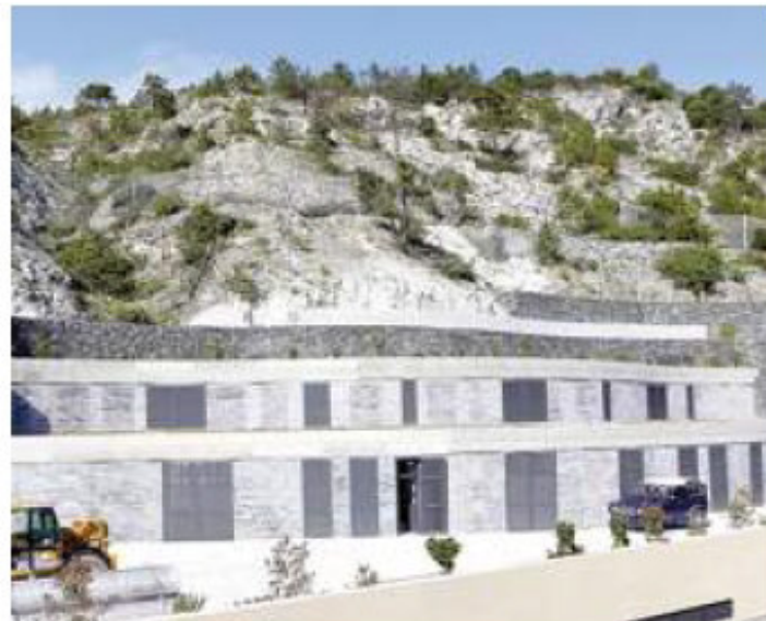
Il depuratore di Levanto
