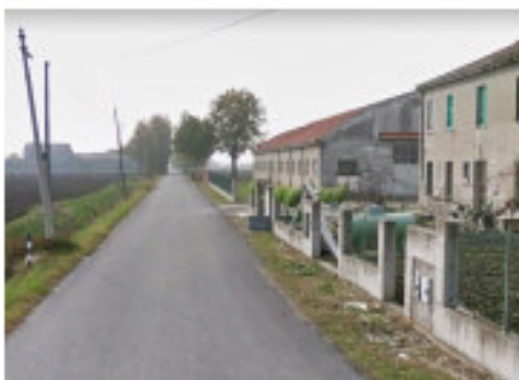
Nuovo depuratore a Poggio, intervento da 3,2 milioni
