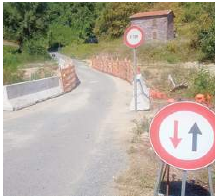
Il ponte sulla provinciale per Cassana riaperto ieri
