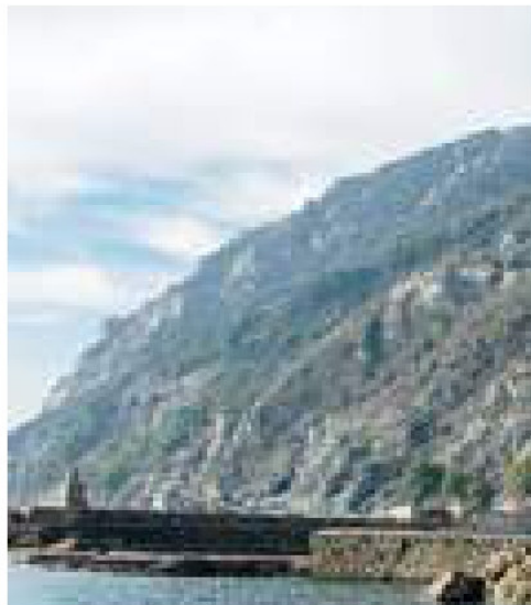
Lo scarico a mare dell'impianto
